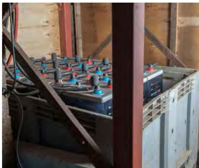
Si la quantité d'énergie est trop faible pour alimenter les batteries — ce qui se passe en général pendant les mois d'hiver — le système peut se servir du réseau national de distribution pour recharger les batteries. Le système est également raccordé à un générateur afin de pouvoir fonctionner indépendamment du fournisseur d'énergie.
