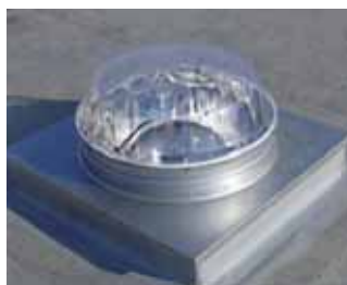
Solin carré installé sur costière Tesco (2009)
